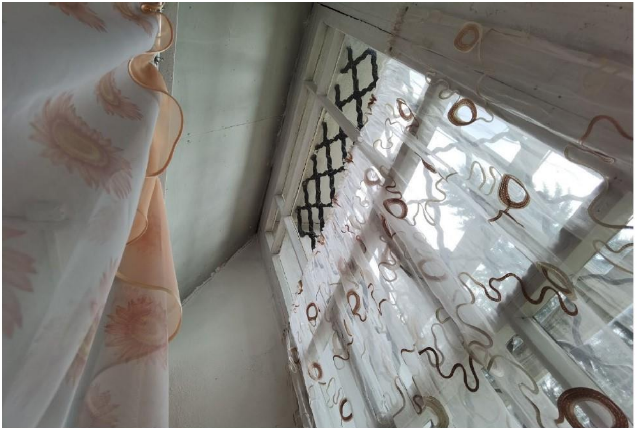
85. Костромская обл., г. Нерехта. Церковь Богоявления (Никольская). Южная палатка. Подшивной потолок, закрывающий коробовой свод перекрытия палатки. Фото июль 2024 г
