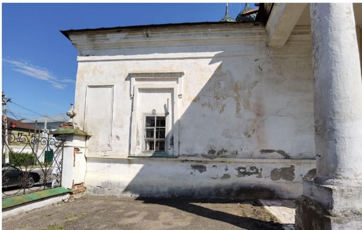
27. Костромская обл., г. Нерехта. Церковь Богоявления (Никольская). Северная палатка. Общий вид с запада. Фото июль 2024 г.
