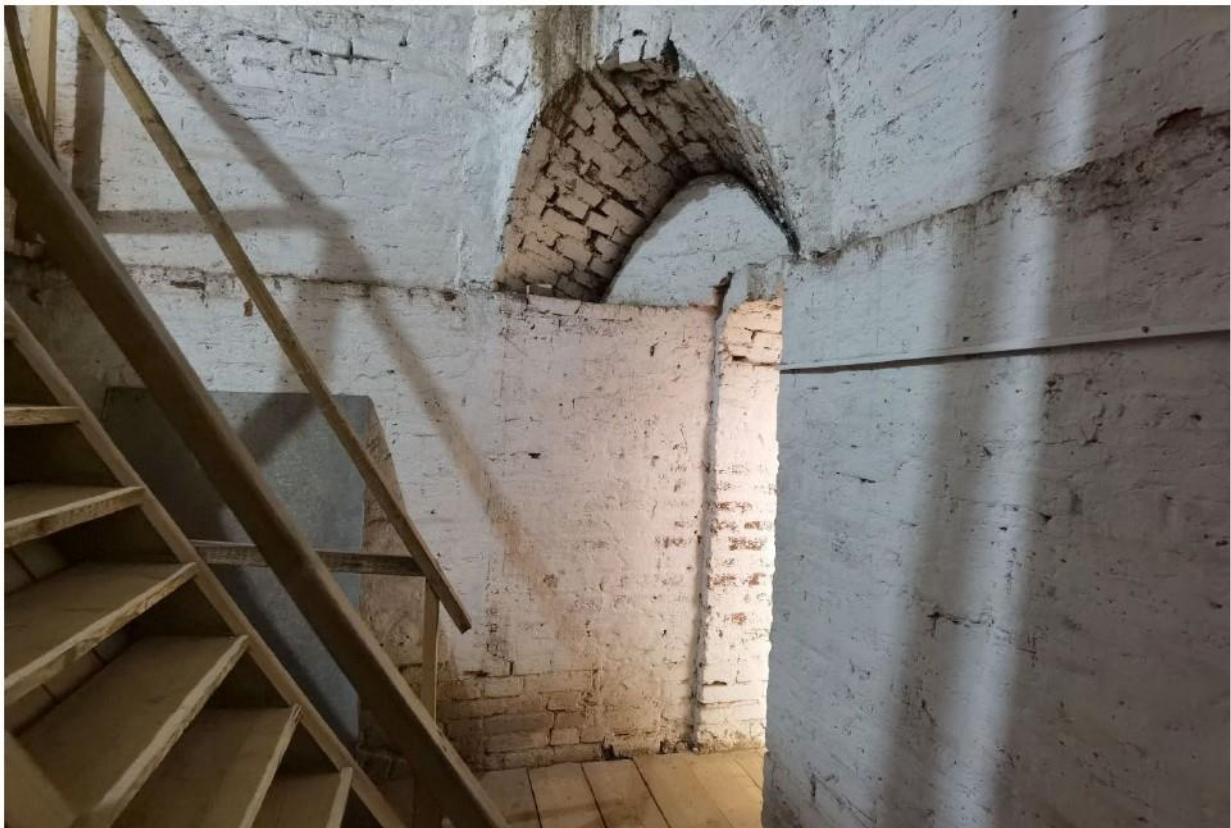
91. Костромская обл., г. Нерехта. Церковь Богоявления (Никольская). Колокольня. Уровень перекрытия . 1-го яруса. Фото июль 2024 г.
