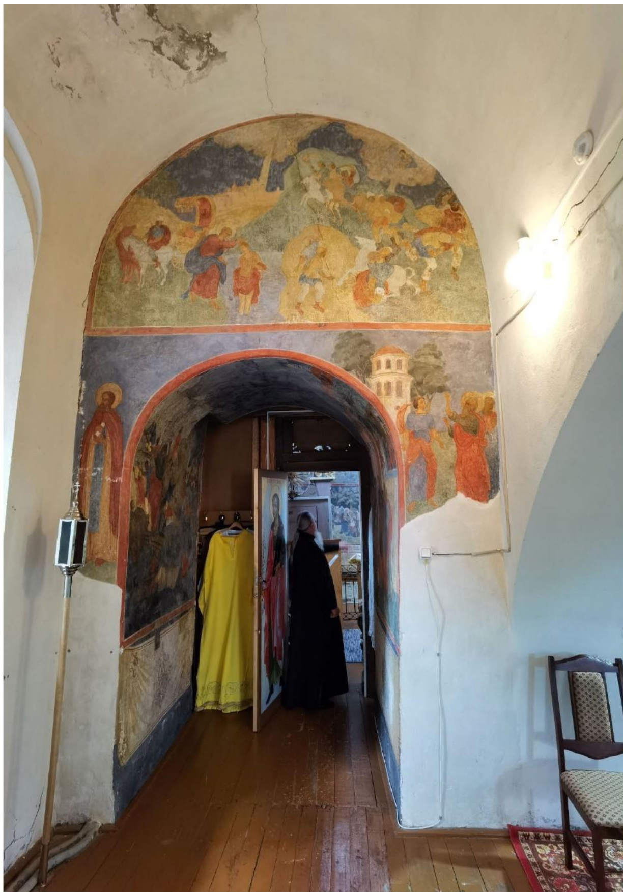
59. Костромская обл., г. Нерехта. Церковь Богоявления (Никольская). Апсиды четверика. Южная часть: роспись над аркой южного проема. Фото июль 2024 г.
