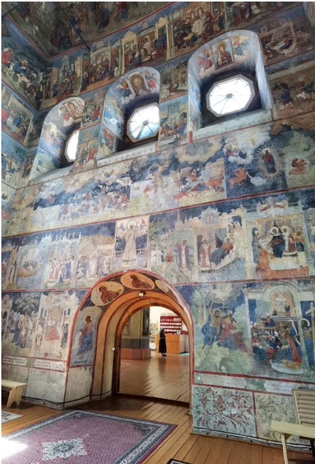
39. Костромская обл., г. Нерехта. Церковь Богоявления (Никольская). Четверик. Западная стена. Фото июль 2024 г.
