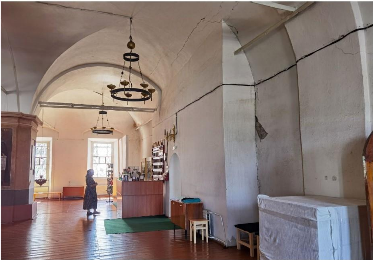
64. Костромская обл., г. Нерехта. Церковь Богоявления (Никольская). Трапезная. Вид вдоль западной стены в сторону южного фасада. Фото июль 2024 г.
