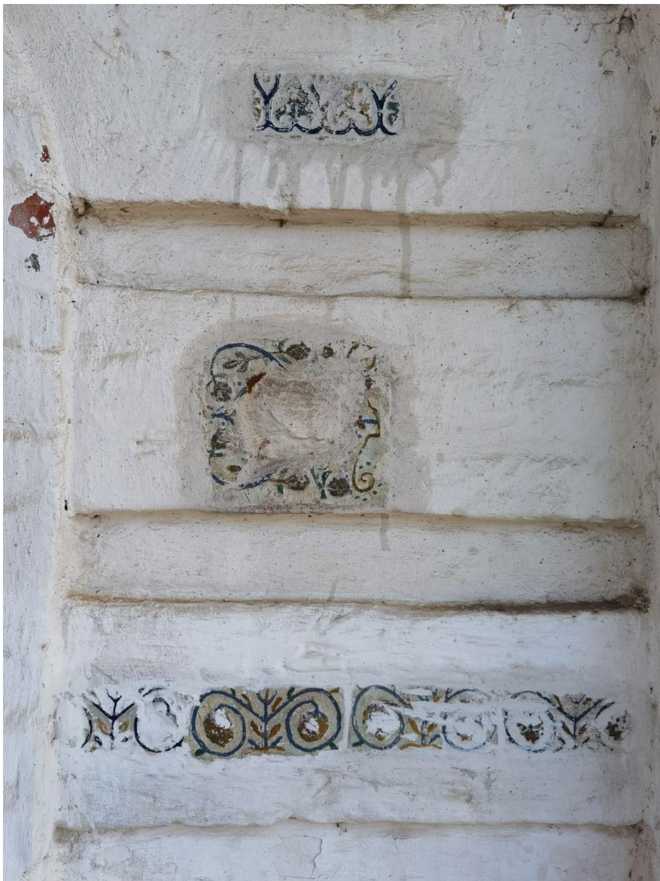
32. Костромская обл., г. Нерехта. Печные изразцы на западном фасаде колокольни. Фото июль 2024 г.
