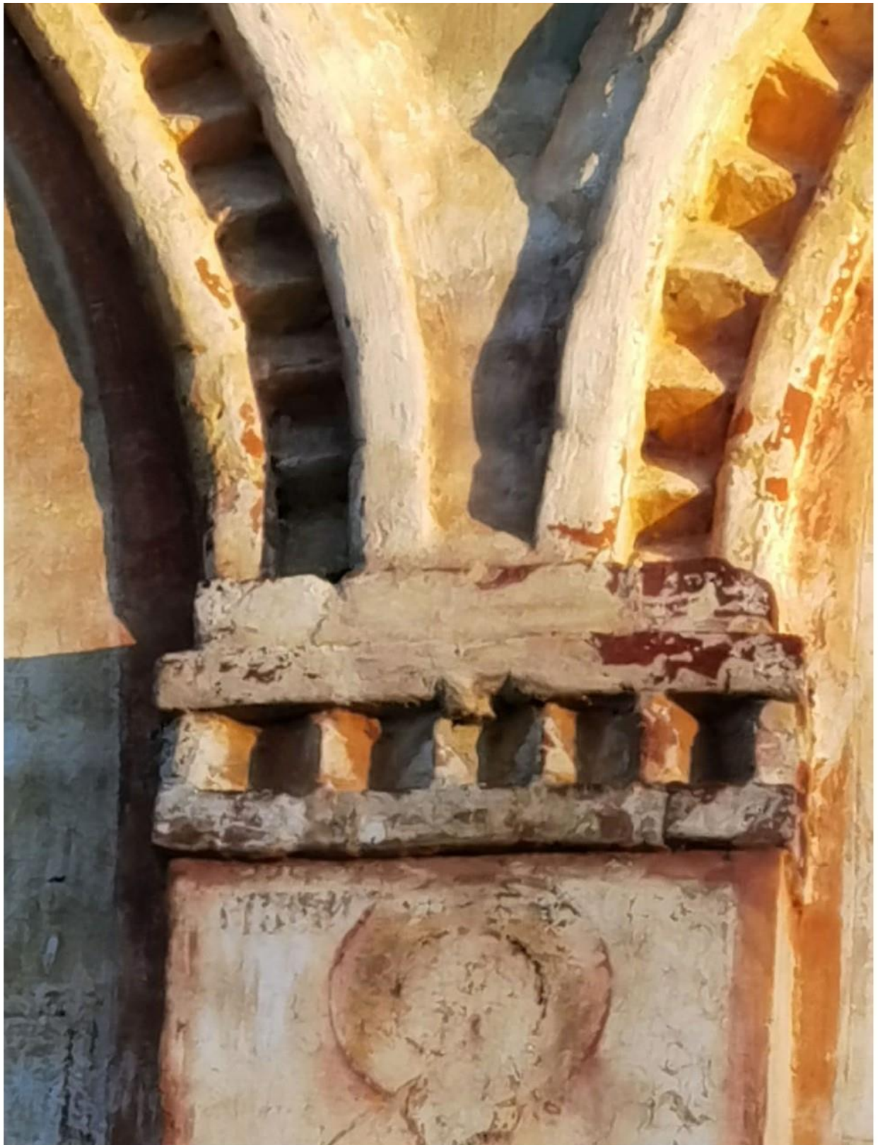
15. Костромская обл., г. Нерехта. Церковь Богоявления (Никольская). Оформление архивольтов ложных закомар и пилонов.
