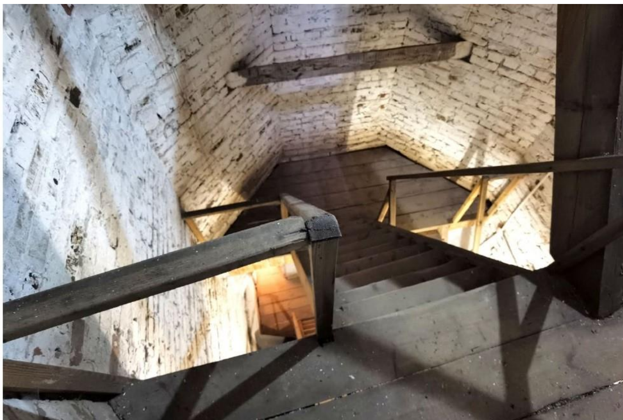
94. Костромская обл., г. Нерехта. Церковь Богоявления (Никольская). Колокольня. Деревянная лестница на ярус звона. Промежуточная площадка. Фото июль 2024 г.
