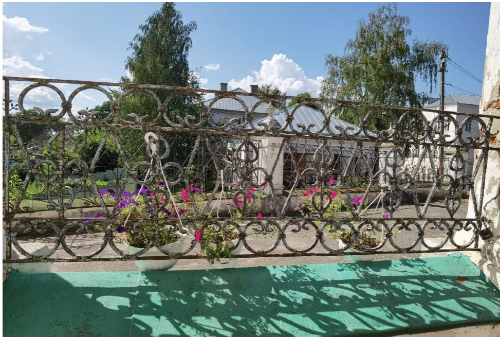
37. Костромская обл., г. Нерехта. Церковь Богоявления (Никольская). Парапет и кованая решетка западной паперти. Фото июль 2024 г.
