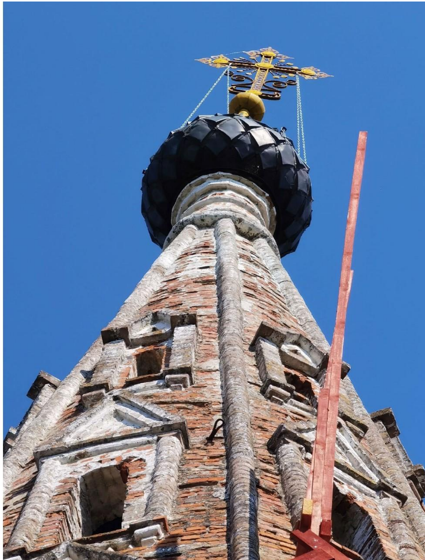
38. Костромская обл., г. Нерехта. Церковь Богоявления (Никольская). Колокольня. Декор шатра. Фото июль 2024 г.
