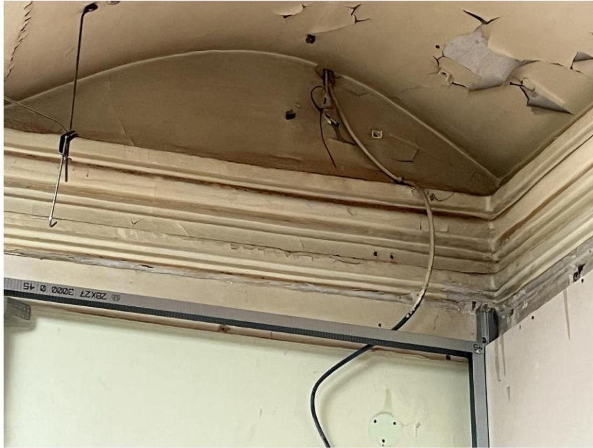
Тянутый потолочный карниз 1-го этажа
