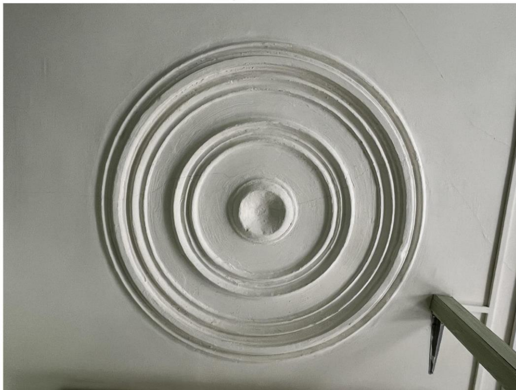
Тянутая потолочная розетка в помещении 2-го этажа
