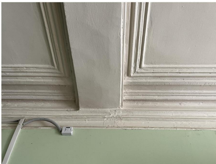
Тянутый потолочный карниз 2-го этажа. Потолочная балка
