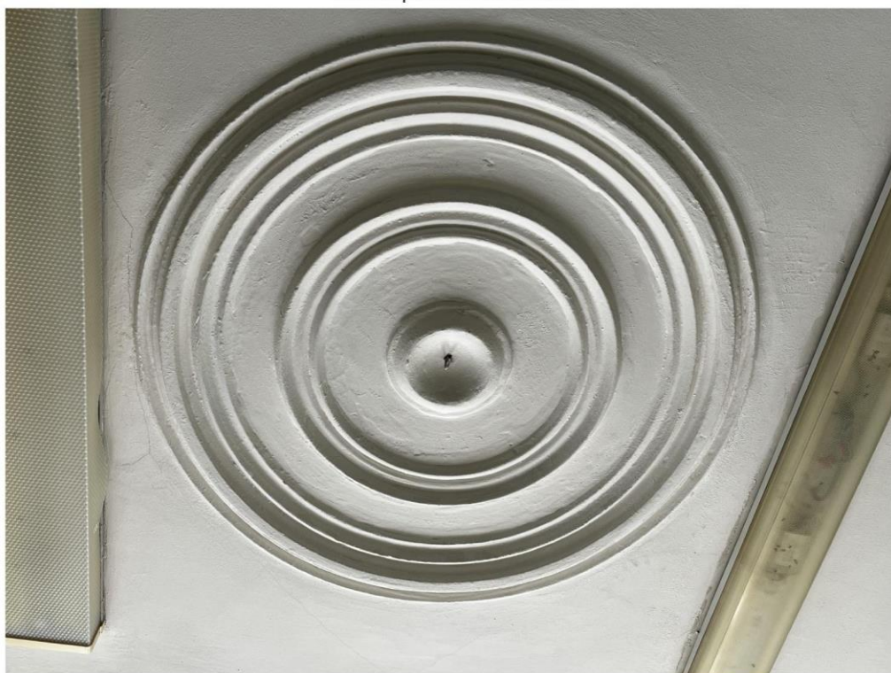
Тянутая потолочная розетка в помещении 2-го этажа
