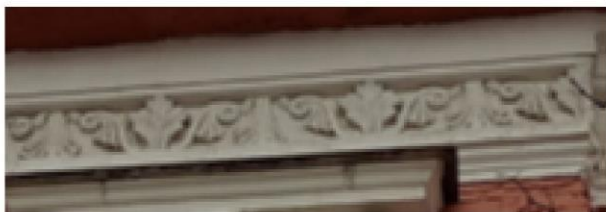
Венчающий карниз южного, западного и восточного фасадов.
