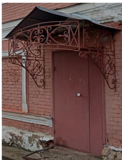
Навес 2. крыльцо входа восточного, фасада.
