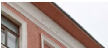
Вид выноса крыши.
