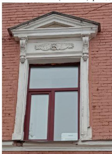
Оформление оконных проемов второго этажа слабо выступающего ризалита главного (южного) фасада.
