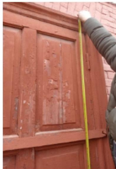
2. Дверное заполнение входа западного фасада.
