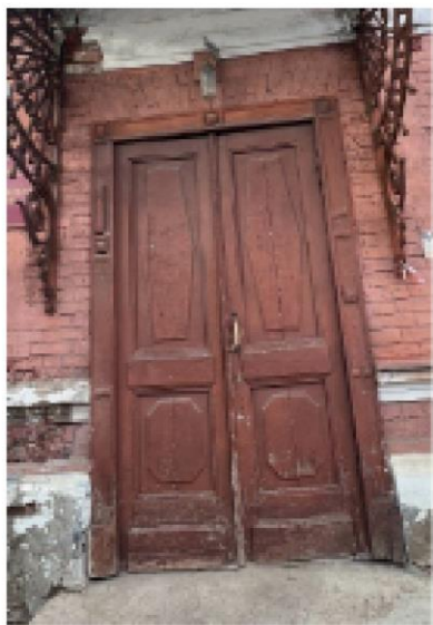
1. Дверное заполнение входа главного, южного фасада.
