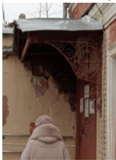
Навес 3. крыльцо входа восточного, фасада.
