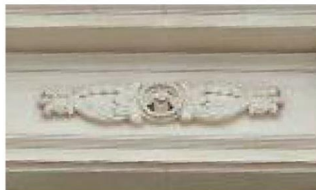
Фриз между кронштейнами сандрика.
