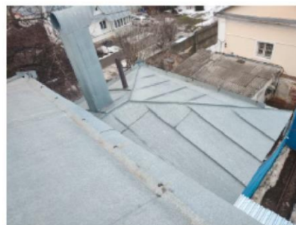
Вид кровли ризалитов.
