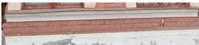
1-й этаж. Профилированный карниз над цоколем.
