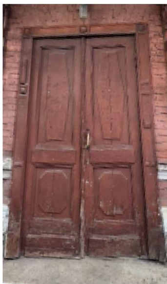
Оформление дверного проема входа главного (южного) фасада.
