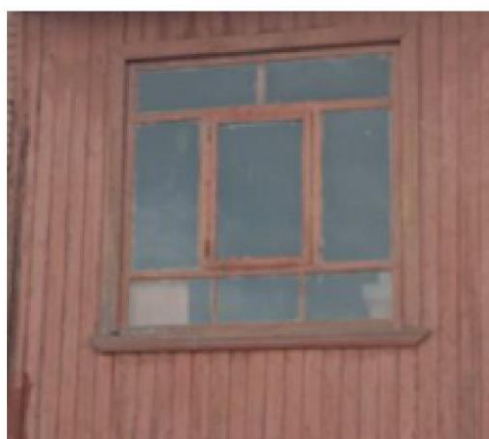
Оконное заполнение переходного тамбура-лоджии.
