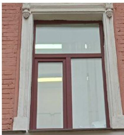
Оконное заполнение двустворчатое, с фрамугой.
