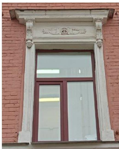
Оформление оконных проемов второго этажа южного, западного и восточного фасадов.
