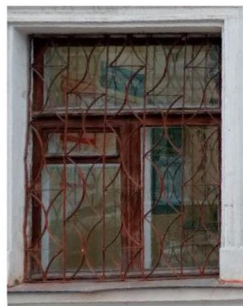
Оконное заполнение двустворчатое, с фрамугой и форточкой
